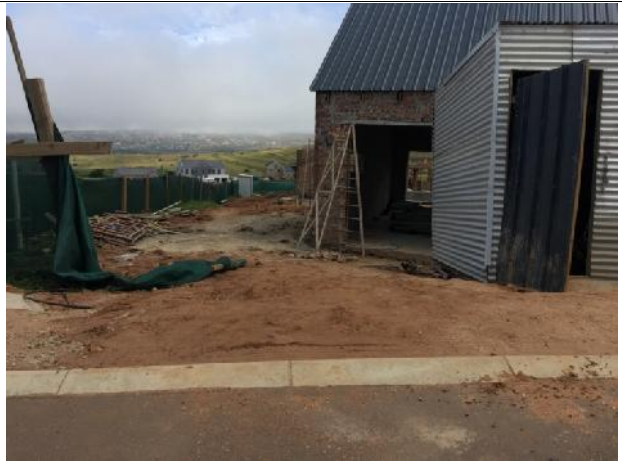
Individual house construction (Erf 6544)
