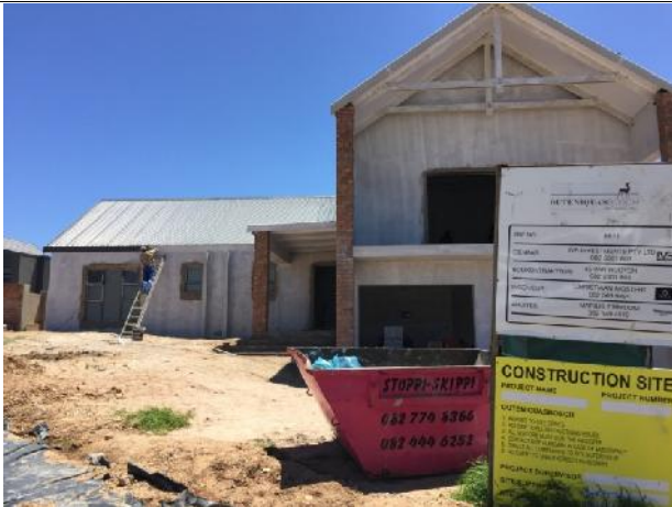
Individual house construction (Erf 6644)
