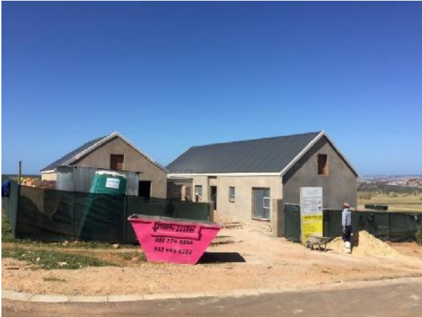
Individual house construction (Erf 6590)
