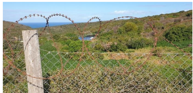
Effluent discharge dam.
